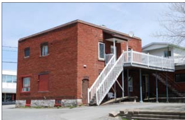
façades arrière et latérale droite
