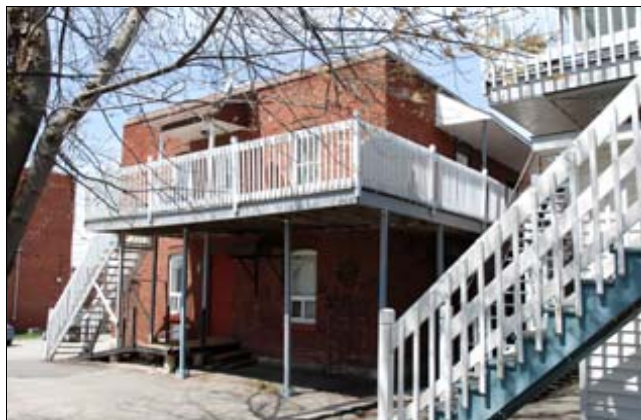
façades latérale gauche et arrière
